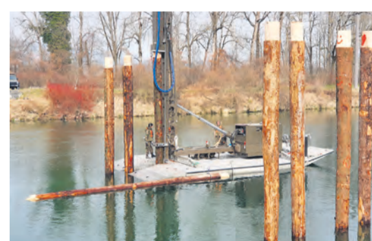
Die wichtigste Aufgabe eines Rammzugs ist: mit einer schwimmenden Ramme Holzpfiler zur Verankerung von Stahlträgerbrücken in den Fluss- oder Seegrund zu treiben.
